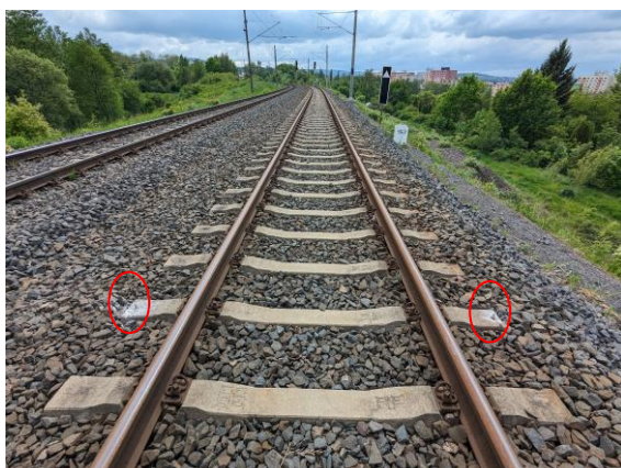
Geodetické body na pražci 1.TK v profilu PR III
